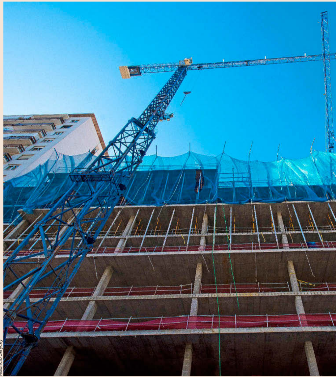
En la imagen, un edificio de viviendas en construcción, en Madrid. La capital vive una fuerte recuperación y registró un en-
